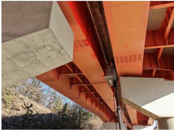
고소점검차를 이용한 부재치수 현장측정
