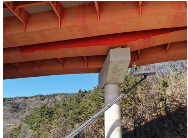
고소점검차를 이용한 부재치수 현장측정
